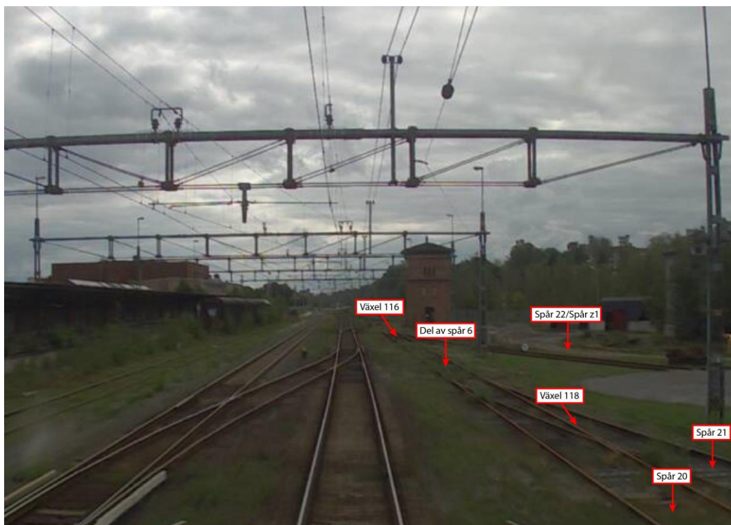
Figur 6: Bild på del av spår 6 mellan växel 118 och växel 116 (bild med riktning mot söder).
